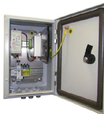
Montáž do venkovního rozdávěče OH3215
