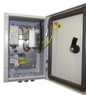
Montaż w rozdzielnicy zewnętrznej OH3215
