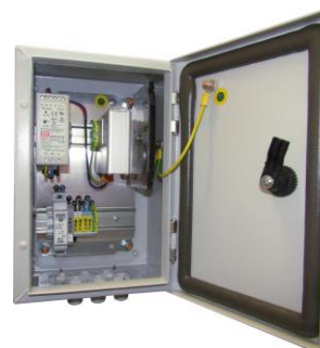
Montaż w rozdzielnicy zewnętrznej OH3215
