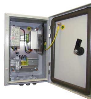
Montaż w rozdzielnicy zewnętrznej OH3215
